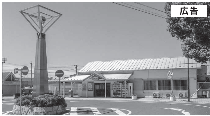
●2面2線の相対式ホームを有し、青い屋根瓦が印象的な駅舎の地上駅。
