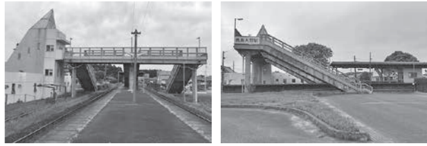
●ホームは島式で1面2線。風雨をしのげる待合室もある。 ●駅の東側は東西自由通路で結ばれている。
