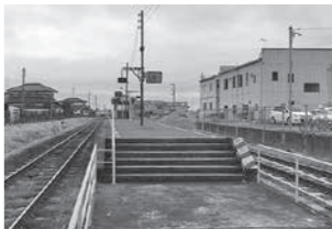
●下館側に構内踏切がある。
