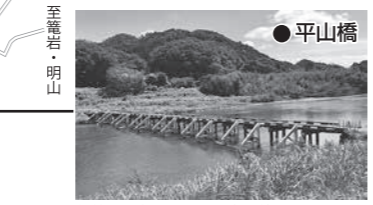
●平山橋 久慈川に架かる欄干が低く美しい木製の沈下橋。昨年の台風で車は通行不能になっていたが、地域の人々の移動には重要な橋だ。
