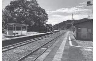
●2面2線のホーム
