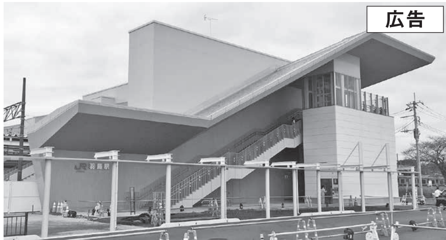
●駅東側の住民にとって念願だった東口が開設。新しい橋梁駅舎は駅名から鳥が羽ばたく様子をモチーフにしている。現在は東西のロータリーを整備中。
