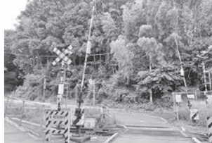
●駅への入口となる第一勝田街道踏切
