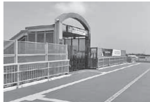
●跨線橋が駅の入口
